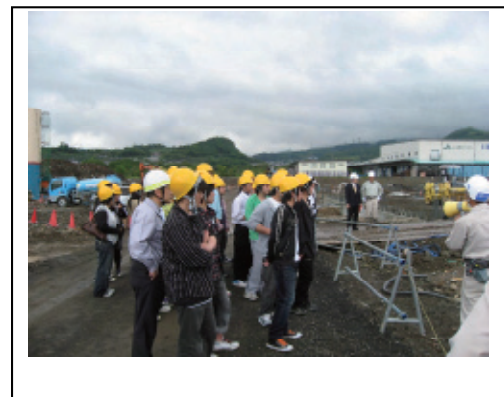
写真4. 現場見学(清水建設)
