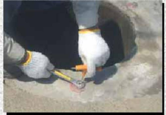
鉄蓋取替工事においてアンカー取付後、接着剤の硬化を待たないで、直ちに、連続して作業ができます
