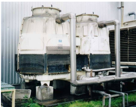
クーリングタワー現場写真
