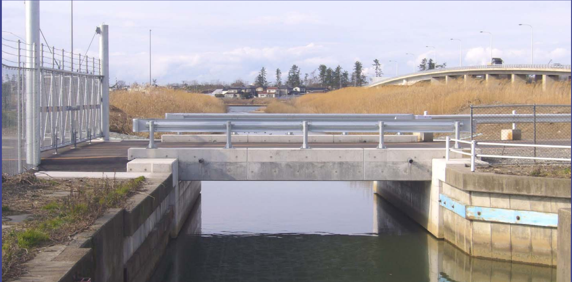
金沢港鞍月用水路橋 橋長9.20m 鋼管杭・鋼矢板併用基礎式ラーメン橋 石川県金沢市(平成18年12月架)
