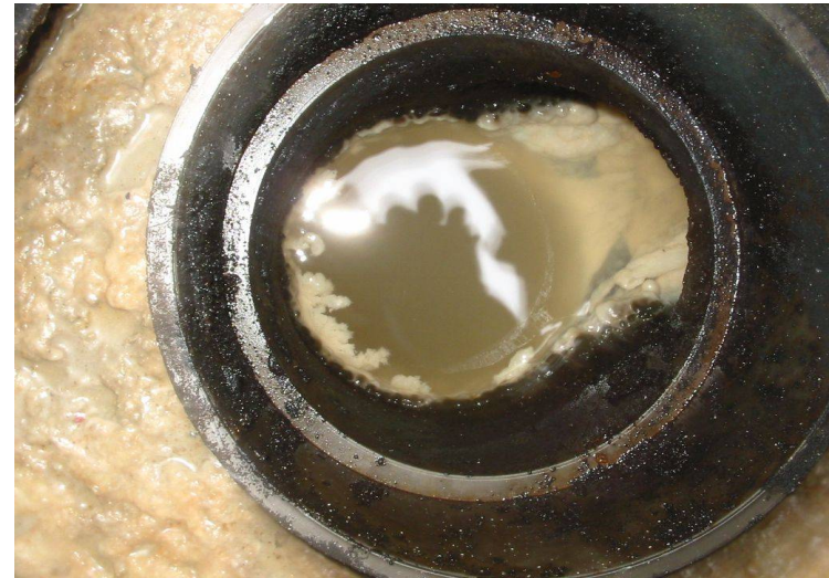
下水配管に繋がる流出口
