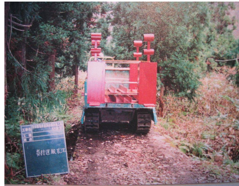
■ 鋼製通し横桁運搬
