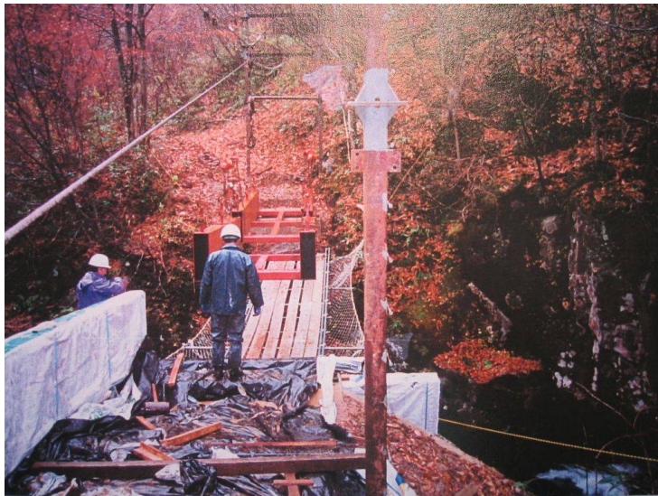
■ 第2セットの架設
