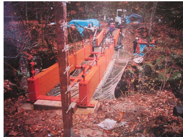
■ 第3セットの架設
