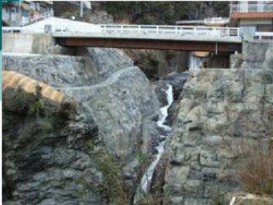
山梨県 勝沼堰堤
