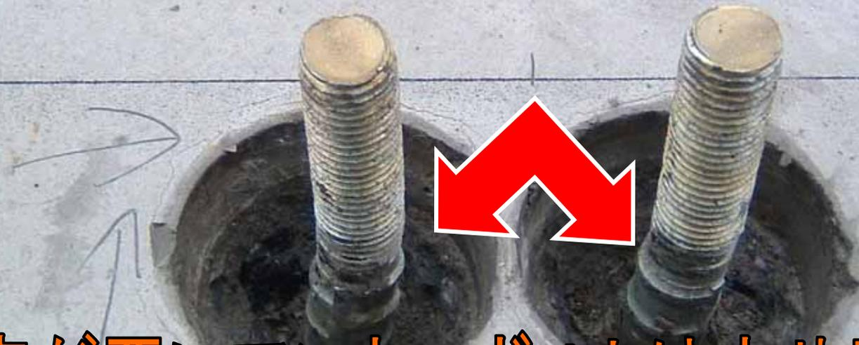
精度が悪いアンカーボルトは力や熱を加えて正しい位置に矯正⇒アンカー台直し
