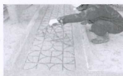
⑤ゴム型枠撤去
