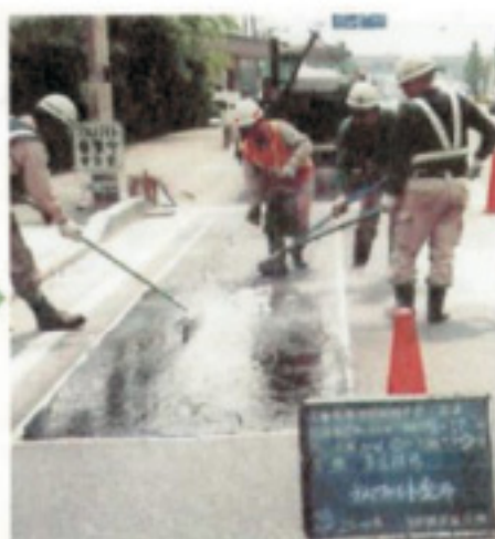
ラバファルトの塗布 (3kg/m 2 )
