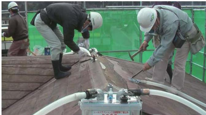
図3 アスベスト瓦解体工事
