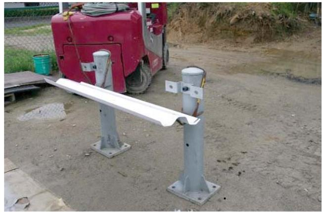
図2 ビーム仮置き状態（治具上に手放しで置ける）
