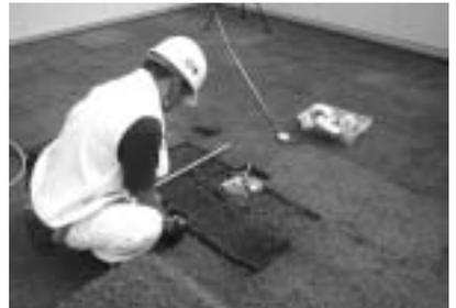
図2 「エコグリーンマット」の施工例。マットの上に芝を張り、レイアウトする
