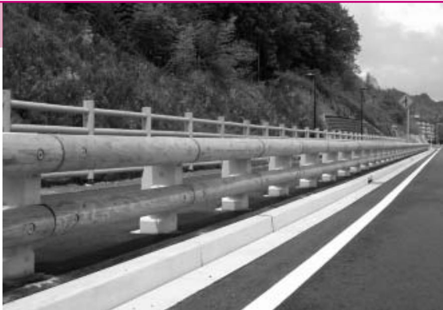
図2 九州の高千穂バイパス218号に設置した「ウッドGr」
