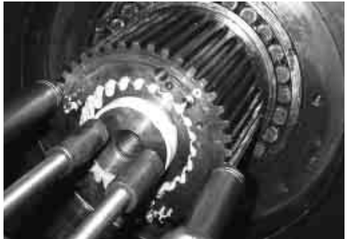
図2 施工の様子。穴から高圧で注入した樹脂がすり減った歯車のすき間を埋めてから外にはみ出ているのが分かる
