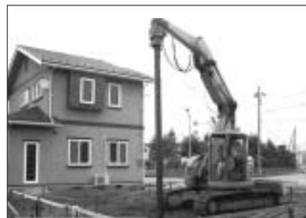
図 住宅地でのブレードパイルの施工状況
