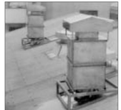
図2 高温の排気口に消音器を取り付けた
