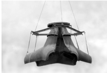
4脚ブロックから型枠を分離した状態
