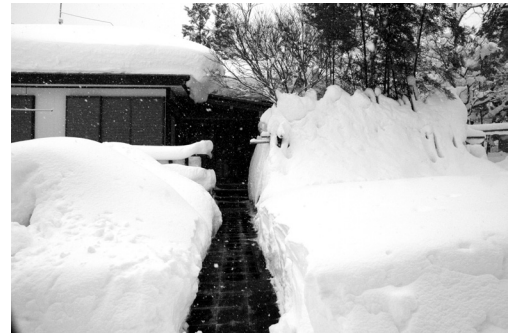
融雪状況 雪大将を敷設した部分は完全に雪が溶けている
