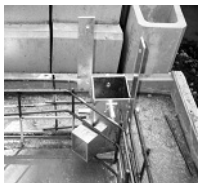
金属製ボックス据付状況
