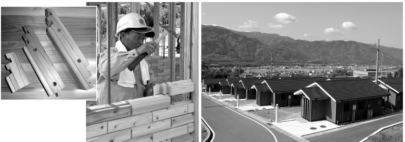
特許となっている積み木状の壁面用ブロック(左)と、建築が進む三好タウン“愉流里(ゆるり)”の積み木住宅
