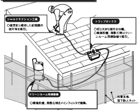
シールドサクシオン工法機器、工具の特徴
