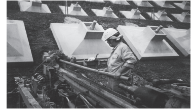
ミストールパイプ（商品名）の挿入状況
