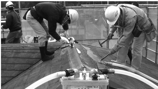
「アスベスト瓦解体工事」
