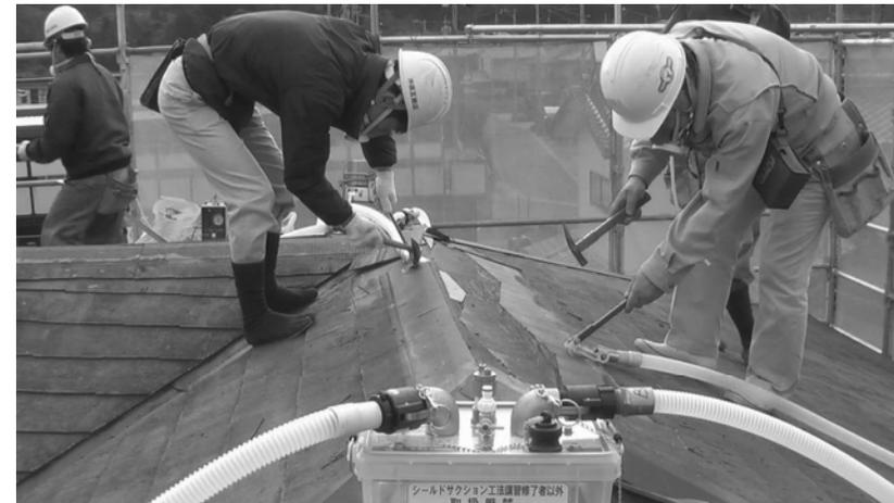
図3 アスベスト瓦解体工事
