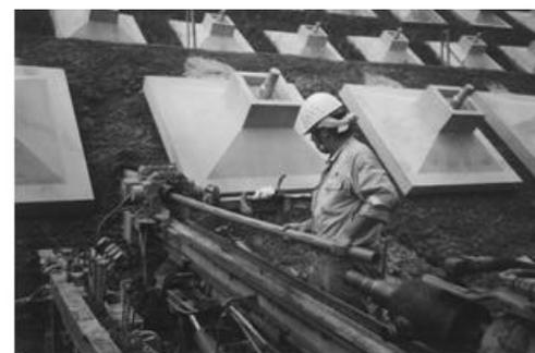
図3 ミズトールの挿入状況
