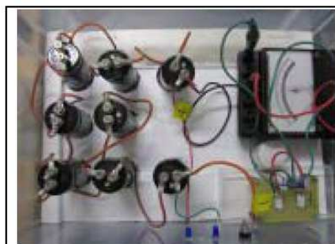
写真4. 電気二重層キャパシタ蓄電システム
