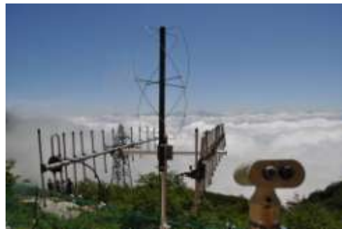
写真7 受信部 (中央上部)
