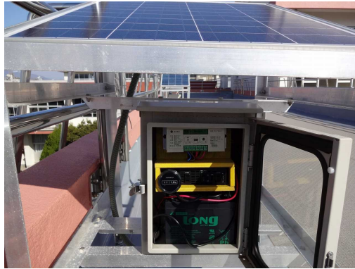
○完成した大型の本体
