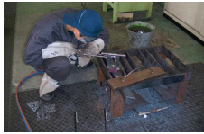
写真5 ガス切断の基本
