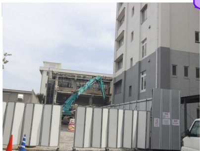
校舎写真（改築中）
