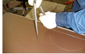
写真3 構造物鉄工のけがき
