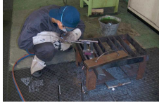
写真5 ガス切断の基本
