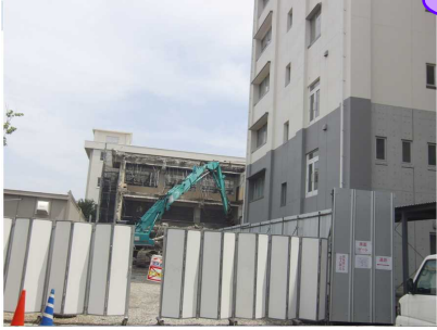
校舎写真（改築中）
