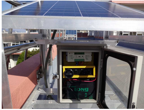
○完成した大型の本体
