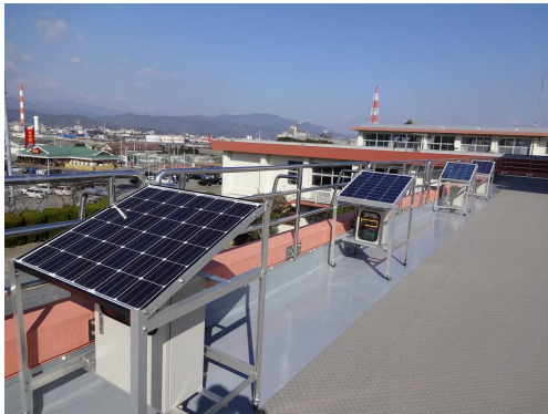
○大型の津波避難誘導灯 4 台の屋上設置状況
