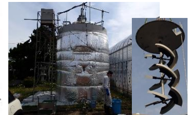
メタン発酵槽 と攪拌機
