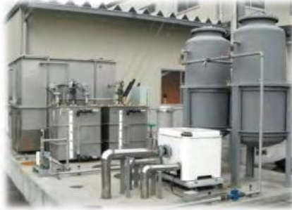
廃水処理装置
