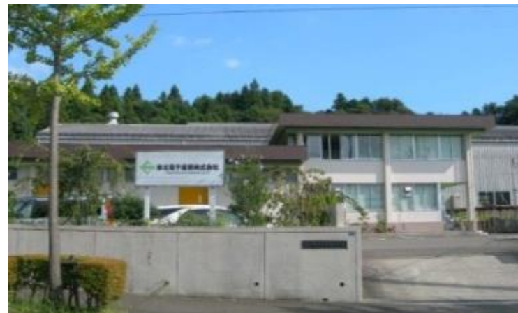
宮城県宮城郡利府町 / 工 場
