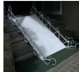
写真11 車いす用移動式スロープ
