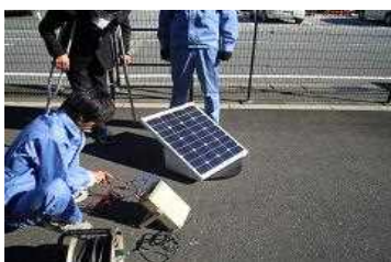
図5. 発電装置製作(1) -太陽光パネル評価-
