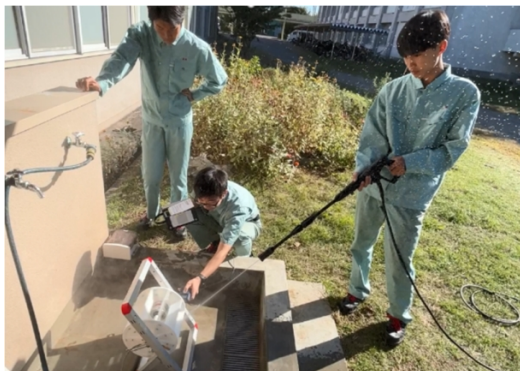
(写真1) 水車装置の設置・実証実験
