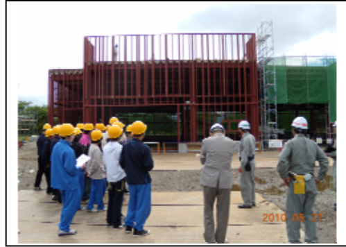
写真2. 現場見学(2 学年)
